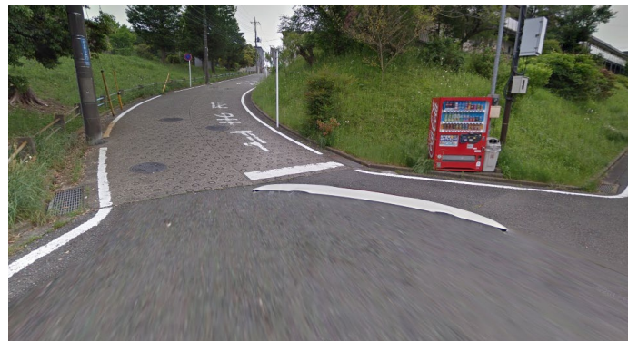
公共空間を撮影している
